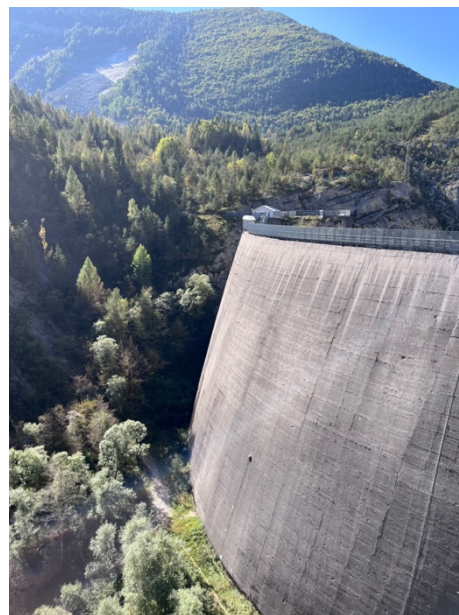
Figura 5: vista della diga da monte; in lontananza il monte Toc
