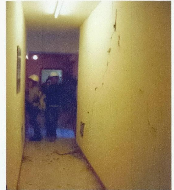
Stato Limite di Danno (Operational) (L'Aquila)
