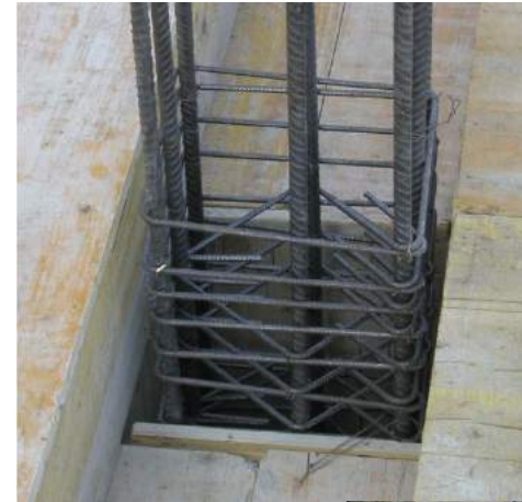
Staffatura corretta di un pilastro
