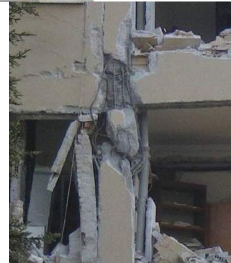
Danni al nodo trave-pilastro, L'Aquila
